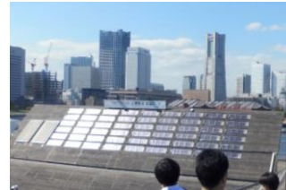
設置されているモジュール（遠景）
