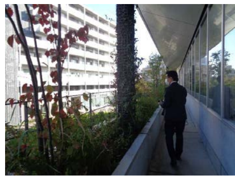
●各階外周部の植栽とジャカゴ樋（2階）
